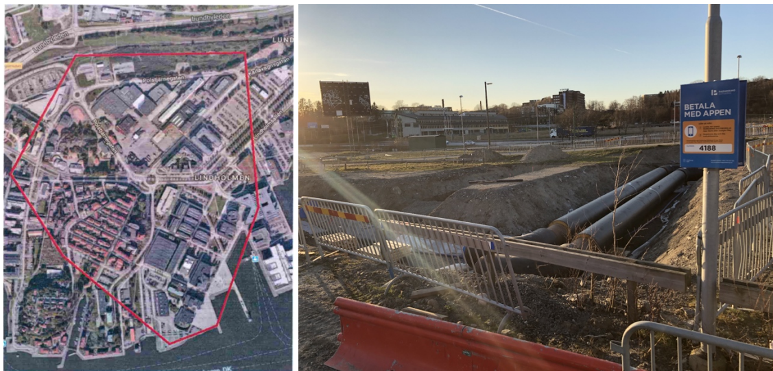
Figur 4. Områdestillstånd vid Lindholmen (t.v.). Den tänkta parkeringen blev utan förvarning en grop med fjärrvärme. Projektets deltagare fick bekosta att en intilliggande parkeringsplats iordningställdes för att pilottesterna skulle kunna genomföras.
